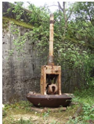
Bild 10: Vor der Haubitzbatterie der Feste Kaiserin: Der erste, bereits abgelassene Turm, noch mit Rohr und Pivotsäule. Vor dem Abtransport mussten die beiden Turmteile noch demontiert werden. [Wernet, 5. Juli 2006]
