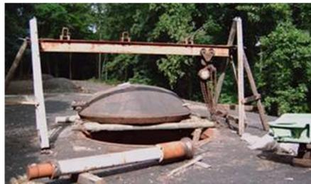
Bild 4: Die leere Kuppel ist angehoben und ruht auf Rundhölzern. Eine leichte Laufkatze ist montiert. Sie dient zum Ablassen der Einzelteile der Turmmechanik, die bereits auf der Batteriedecke zwischengelagert sind. Im Vordergrund die neue Pivotsäule. [ADFM 2004]
