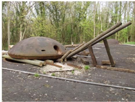
Bild 3: Mit Hebeln wird die leere Kuppel zunächst aus ihrer Kalotte gehoben und auf Rundhölzer gesetzt. [Wernet April 2004]
